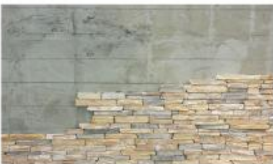
7. 먹줄에 맞게 인조석 붙임 작업
