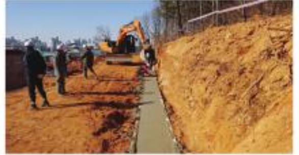
2. 버림콘크리트 타설 (T=10)
