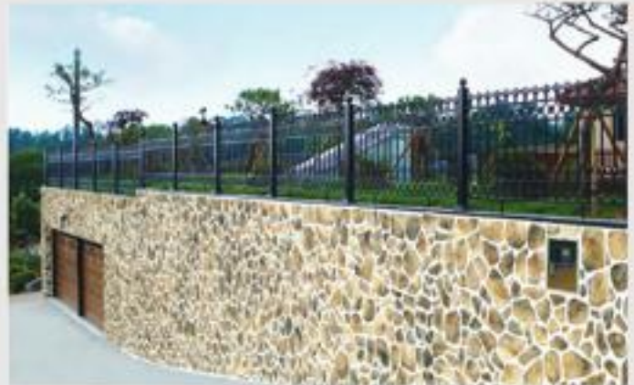
양평군 전원주택 외벽공사
