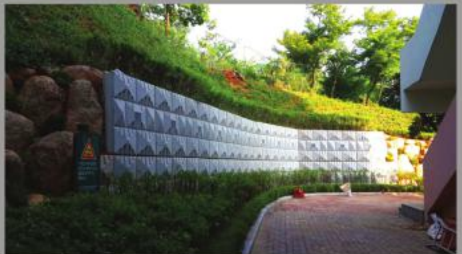
기본 콘크리트 패널 시공현장
