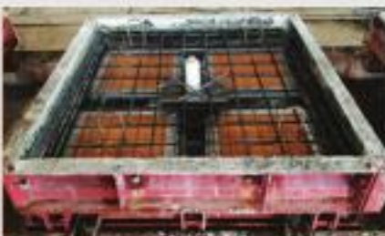
3. 철근배근 및 보강판 설치
