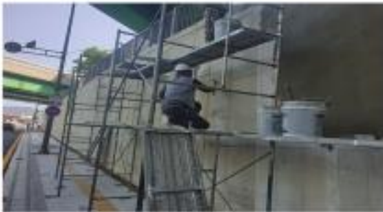
3. 비계 설치 후 상단 작업
